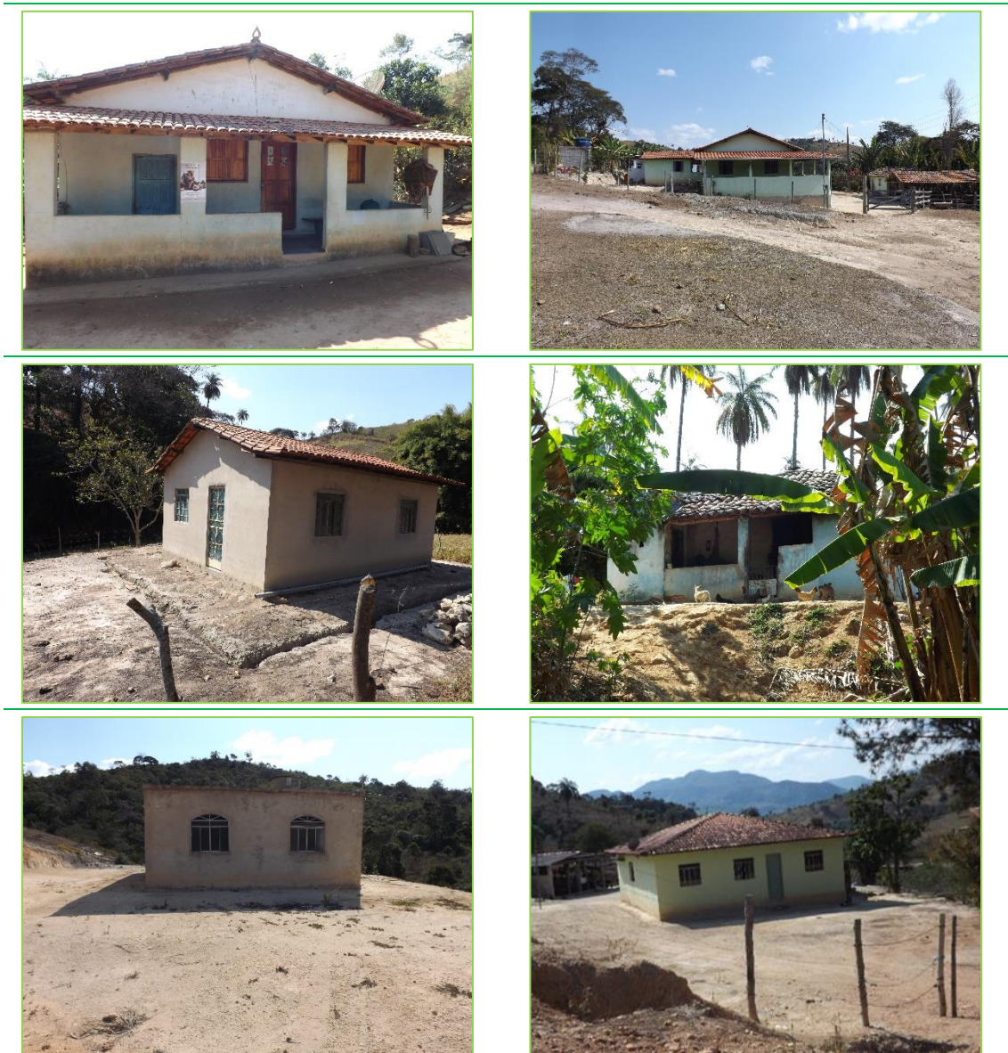
Figura 9.4 – Residências diagnosticadas em Limeira e em Córrego Fundo.
